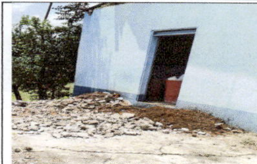
foto 3: Sustitución de puerta En modulo de Cocina
