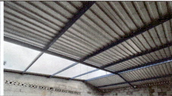
foto 1: Sustitución de lámina, por lámina troquelada aluzinc calibre 26 En modulo de Cocina
