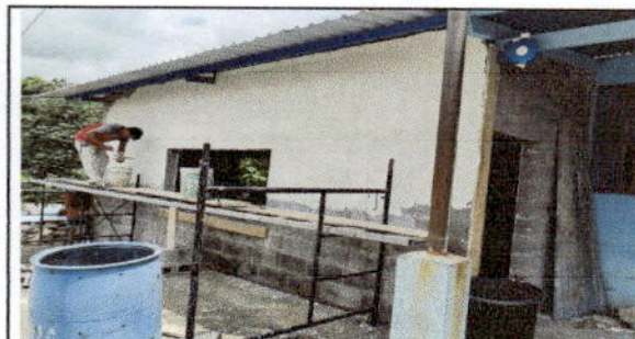
FOTO 7: Repello en muro En modulo de Cocina
