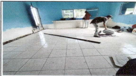
foto 5: Sustitución de piso cerámico En modulo de Cocina
