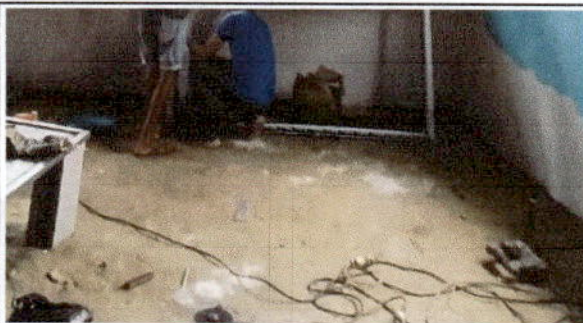
foto 4: Sustitución de piso de torta de concreto En modulo de Cocina
